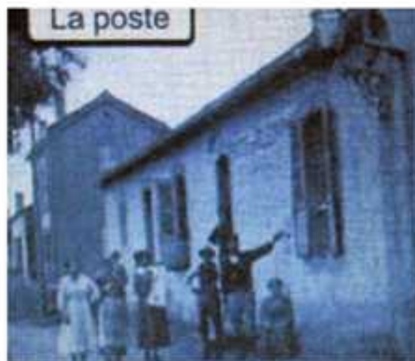
le 1er bureau de Poste de Aïn-Bessem
