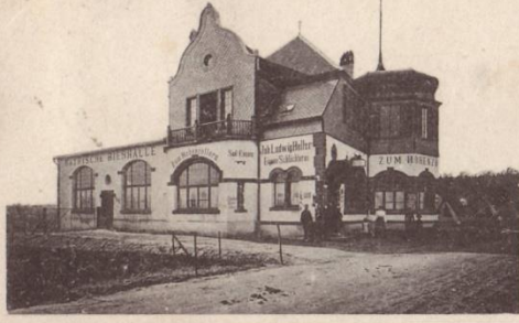
Restauration zum Hohenzollern
