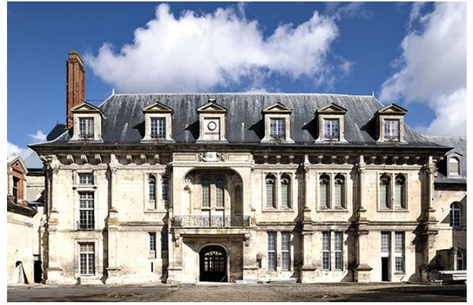
Façade Sud, sur cour des offices (avec grand escalier, chapelle et jeu de paume)
