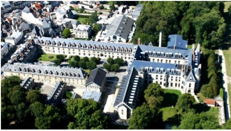
Vue générale du château de Villers-Cotterêts, avec la cour des offices et le logis principal.
