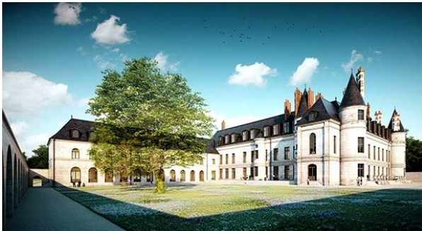
Angle Nord-Est du château, vue du jardin des dames © Olivier Weets, architecte M.H.
